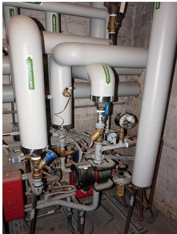
Rys. 1.4 Węzeł cieplny
