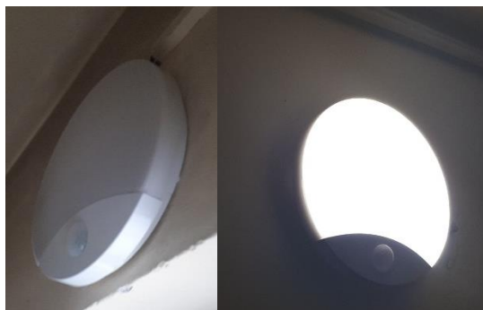
Rys. 3.19 Oprawy LED z czujnikami ruchu i zmierzchu zainstalowane na klatce schodowej w budynku wielorodzinnym
