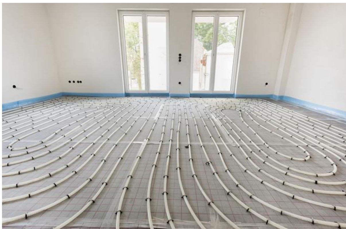
Rys. 3.8 Instalacja ogrzewania podłogowego
